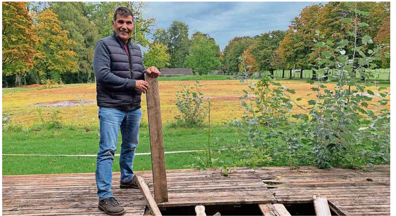
Ruedi Wolfender auf dem morschen Deck des Clubhauses. Am 4. November startet der Rückbau.
