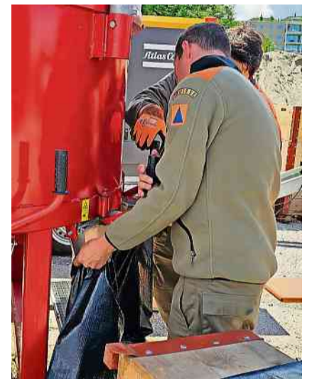
Rund 5700 Sandsäcke wurden abgefüllt.
