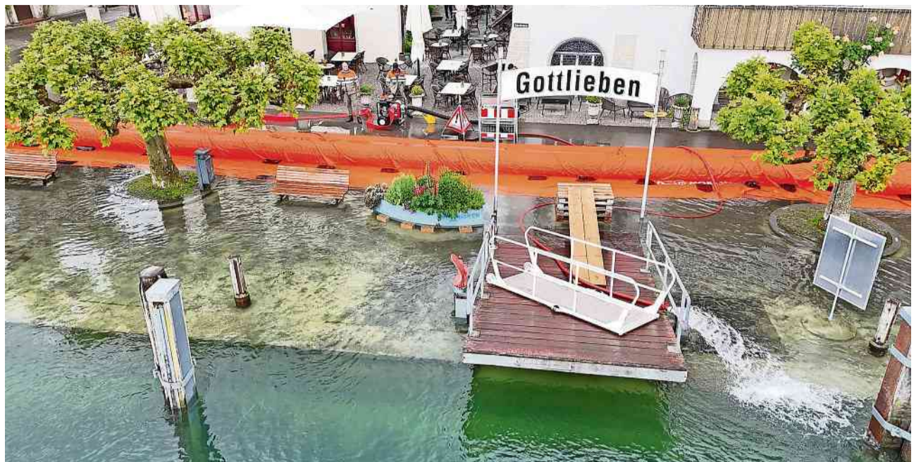
Um einen Rückstau des Wassers von der Seepromenade ins Dorfinnere zu verhindern, wurden Pumpen eingesetzt.
