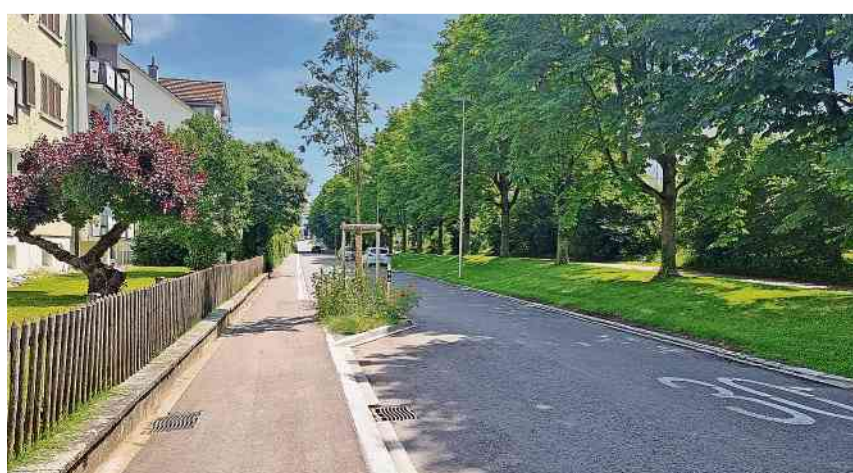
An der Brückenstrasse wird ein neuer Deckbelag eingebaut.
