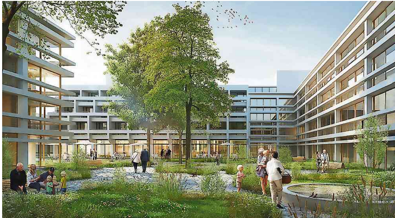
Im neuen «Haus C» stehen insgesamt 63 barrierefreie, lichtdurchflutete Wohnungen für ein selbstständiges und komfortables Leben zur Verfügung.
